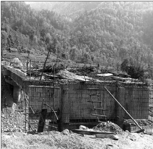
मुल्मीको सत्यवती गाउँपालिका-२, धुसेनी र स्याङ्गजाको कालीगण्डकी गाउँपालिका-४ विद्या जोड्ने पक्की निर्माण हुँदै । कालीगण्डकी नदीमा पक्की पुलको अन्तिम ढलाईको कार्य हुँदै छ । तस्वीर : जनवीन भट्टराई / एनजेडी
